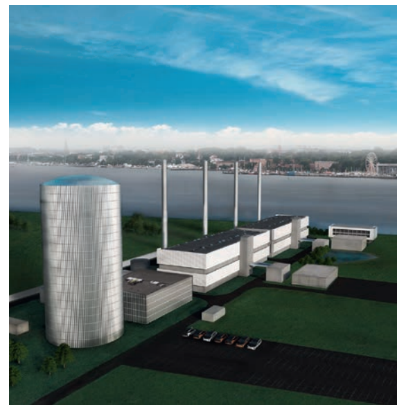
Küstenkraftwerk K.I.E.L. Foto/Copyright: Stadtwerke Kiel
